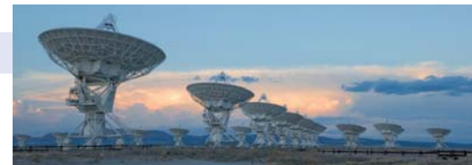
Das „Very Large Array (VLA)“ ist eine Sammlung von 27 Radioantennen, die sich am NRAO-Standort in Socorro, New Mexico, befinden. Jede Antenne misst 25 Meter (82 Fuß) im Durchmesser und wiegt etwa 230 Tonnen.
